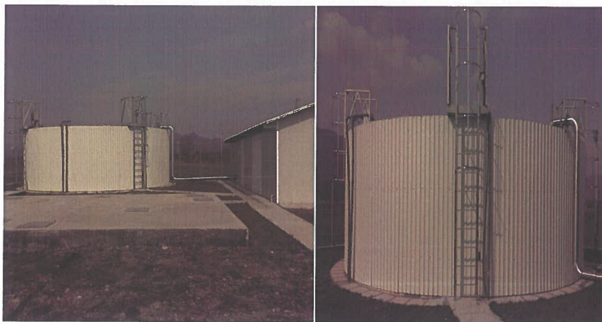
Stație de epurare Păltinoasa – finanțare F.E.A.D.R Măsura 322
