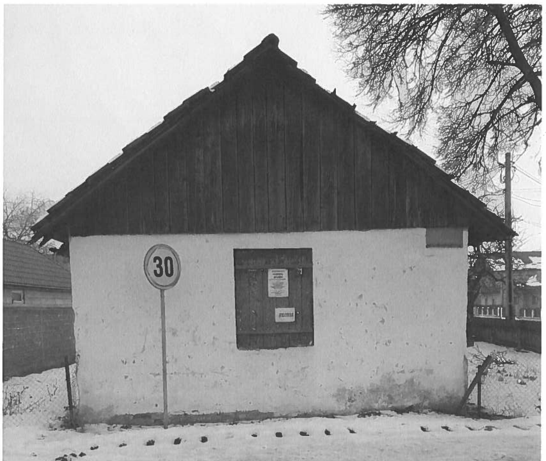
FAȚADA LATERAL STÂNGA CLĂDIRE P.S.I.
