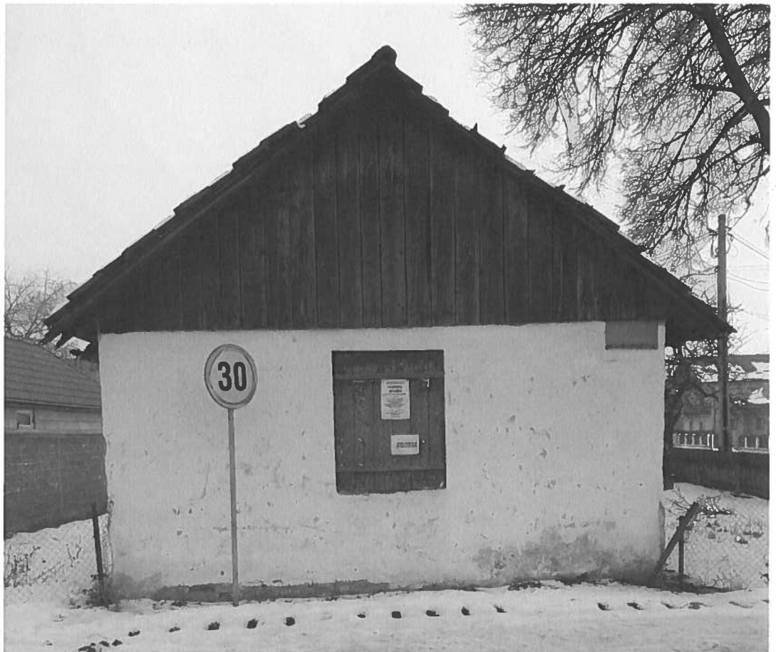
FAȚADA LATERAL STÂNGA CLĂDIRE P.S.I.
