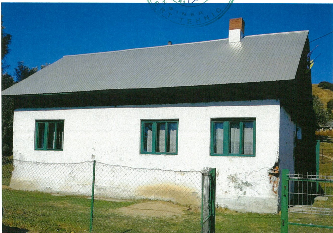
FAȚADA LATERAL STÂNGA
