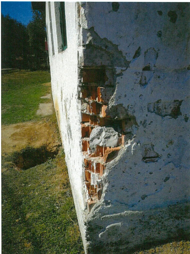
DETALIU DEGRADĂRI ZIDĂRIE LA COLȚURI (FĂRĂ STĂLPIȘORI DE CONFINARE)
